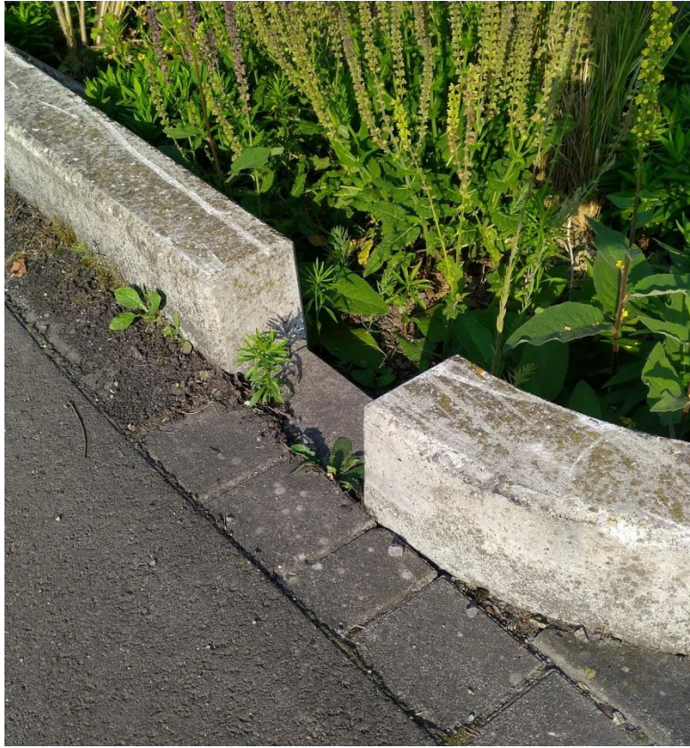
Abbildung 02: Regenzulauf einer dezentralen Regenwasserversickerung in Löhne-Mennighüffen
