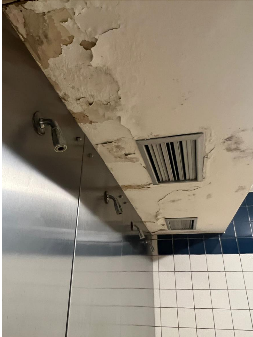
Abbildung 02: Duschen am städtischen Gymnasium - hier: Ablüftung
