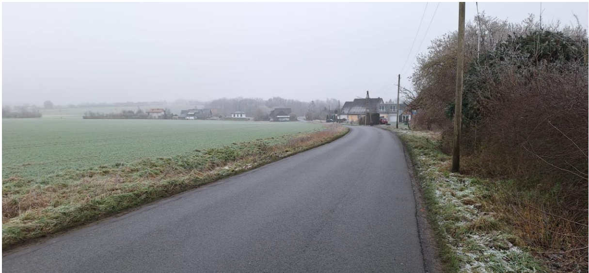
Abbildung 02: Die Straße „Alter Salzweg“ im oberen Bereich
